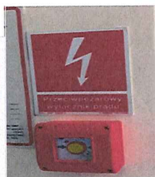
Foto 2 Wyłącznik prądu
